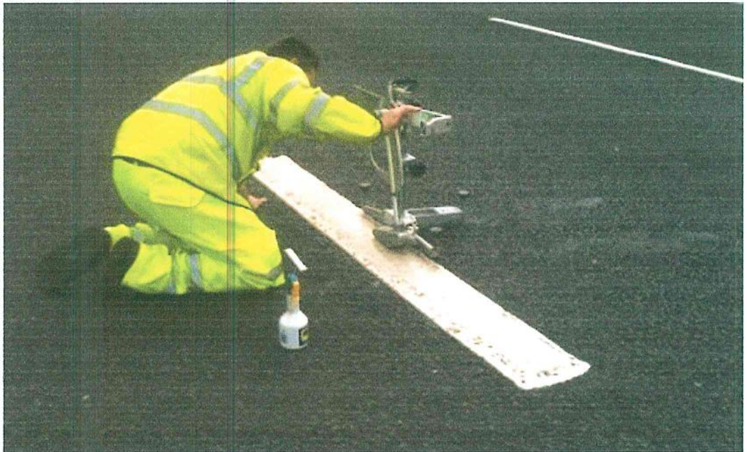
Gambar 41. pengujian kekesatan permukaan Marka Jalan berupa tanda
