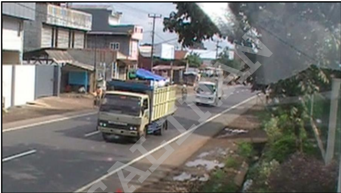
Gambar 6-17. Tipikal jalan 2/2-TT, jalan arteri di kawasan semi perkotaan (Jomin Jabar, 2013)
