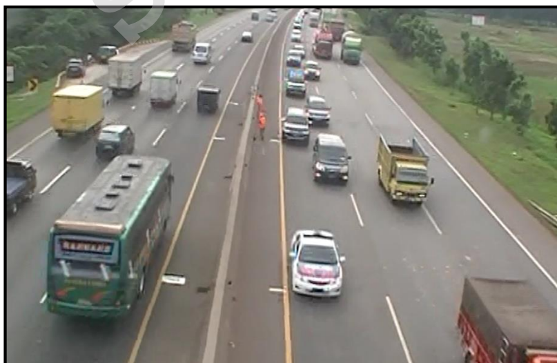
Gambar 6-24. Tipikal JBH 6/2-T dengan median ditinggikan berupa concrete barrier , Jalan Tol Jakarta-Cikampek (2012)
