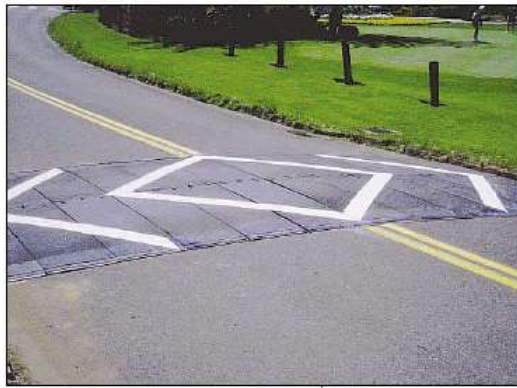
Gambar 26 - Contoh jendolan dengan material karet
