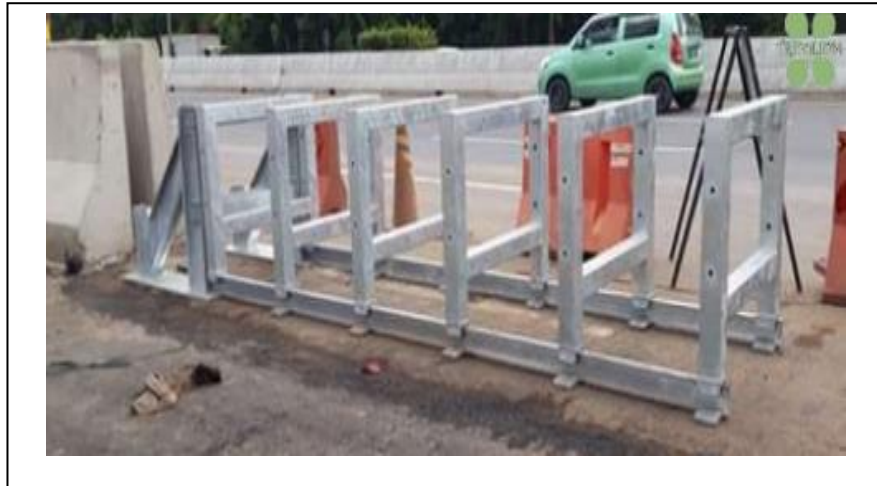
Gambar SKh-1.A.03.1) Ilustrasi Teknis Crash Cushion Frame
